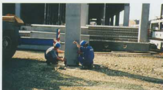
Obr. 4 Osazování sloupu Fig. 4 Column mounting
