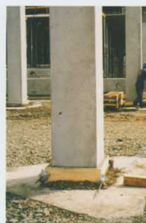
Obr. 6 Zabetonování spáry mezi sloupem a základem Fig. 6 Concreting of a joint between the column and the base
