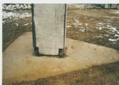
Obr. 6 Zabetonování spáry mezi sloupem a základem Fig. 6 Concreting of a joint between the column and the base
