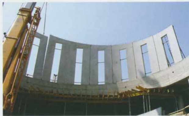
Obr. 10 Montáž prefabrikovaných stěn rotundy Fig. 10 Assembly of prefabricated rotunda walls
