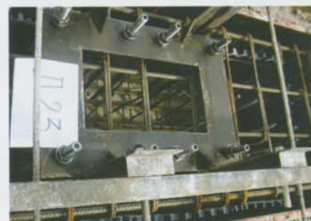
Obr. 2 a) fixace kotevních prvků k bednění, b) ochrana šroubů před betonáží Fig. 2 a) fixing of anchorage elements of the formwork, b) protection of screws from concretin
