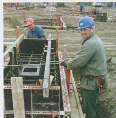
Obr. 1 Montáž kotevních prvků Fig. 1 Assembly of anchorage elements
