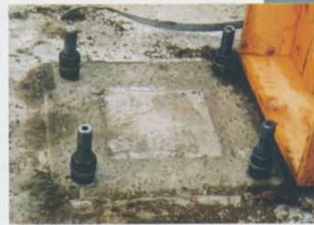
Obr. 3 Základ sloupu před jeho osazením Fig. 3 Column base prior to its mounting
