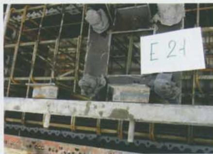
Obr. 2 a) fixace kotevních prvků k bednění, b) ochrana šroubů před betonáží Fig. 2 a) fixing of anchorage elements of the formwork, b) protection of screws from concretin
