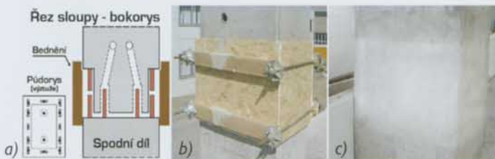
Obr. 4 Prefabrikovaná hala, a) prefabrikované nosné sloupky navazují na základový prvek s vyčnívající výztuží, b) výztuž prefabrikátů byla po usazení sloupky svařena s výztuží spodního dílu a celý prostor byl obedněn, c) čerpáním pod tlakem bylo zajištěno dokonalé vyplnění obedněného prostoru
