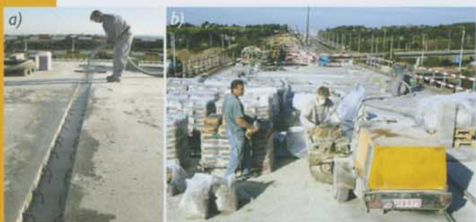
Obr. 8 Montáž příčných desek, a) plnění spár mezi deskami, závlivka i s přídavkem kameniva dobře niveluje, b) šnekové čerpadlo s míchacím centrem pro přípravu závlivkové směsi, c) osazení příčných desek na U nosníky, zvýrazněná kotvící výztuž zasahující do otvorů v deskách, d) protékající závlivka v ložné spáře mezi deskami a U nosníky
