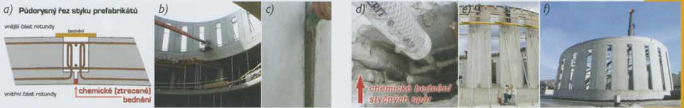
Obr. 3 Zmonolitnění stěnových prefabrikátů při montáži, a) schéma svislých spár mezi obloukovými prefabrikáty, b) obtížná přístupnost místa – cca 10 až 18 m nad terémem, c) čerpání materiálu chemického bednění do spáry mezi panely při jízdě plošiny podél spáry vzhůru, d) dutina průřezu 140 x 185 mm vyplňovaná zálivkou pomocí membránového čerpadla, e) provizorní ochoz vně rotundy, f) prefabrikované prvky zmonolitněné v jeden celek
