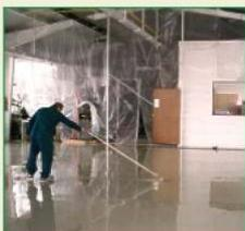
Popis: dvoukomponentní epoxidová průmyslová podlahovina se samonivelačním charakterem pro dosažení rovného, hladkého, barevného povrchu původní podlahy s dobrou mechanickou a chemickou odolností. Podkladem musí být čistý, suchý (vlhkost max. 4%), rovný a vyzrálý beton, potěr nebo anhydrit (28 dní) po řádném ošetřování a pevnosti v tlaku min. 20 MPa s otryskaným (ofrézovaným) povrchem. Pochůznost za 24 hodin, mechanické namáhání po 3 dnech, chemické za 7 dní.
