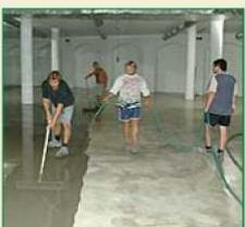
Popis: hladká, bezprašná, samonivelační podlaha na cementové bázi na podklad z betonu nebo cementového potěru, který je tvarově stálý, s pevností v tlaku min. 20 MPa. Slouží jako konečná povrchová úprava nebo jako vyrovnání podkladu před kladením finální podlahové vrstvy v místech s vyšším podlahovým zatížením. Pevnost v tlaku po úplném vyzrání (28 dní) dle typu 25-45 MPa, může být s obsahem vysoce odolných látek (korund, vlákna).
