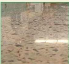
Popis: speciální technologie několikanásobného přebroušení a leštění povrchu stávající betonové podlahy v kombinaci s tmelením prasklin a vytvřením nového povrchu. Nachází uplatnění jak po pokládce nové betonové podlahy (netradiční vzhled), zvláště však při sanacích opotřebovaných povrchních s výborným estetickým výsledkem.
