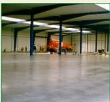
Popis: cementově šedá, hladká a matně lesklá podlaha, bezprašná a minimálně nasáková, svými vlastnostmi vhodná pro lehký, středně těžký i velmi těžký provoz, minimální tloušťka vrstvy 10 cm (pevný podklad), využitelná drátky (drátkobetonová podlaha) nebo sítěmi, pevnost v tlaku minimálně 60 MPa, vysoká otěruvzdornost díky zapracování vsypu PROFIDUR s korundovými příměsemi, řešení dilatační řezem po dokončení povrchu a jejich vyplnění různými systémy dilatačních hmot.
