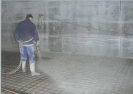
Aplikace můstku přes vyztužnou síť
