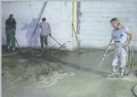
Aplikace můstku před betonáží
