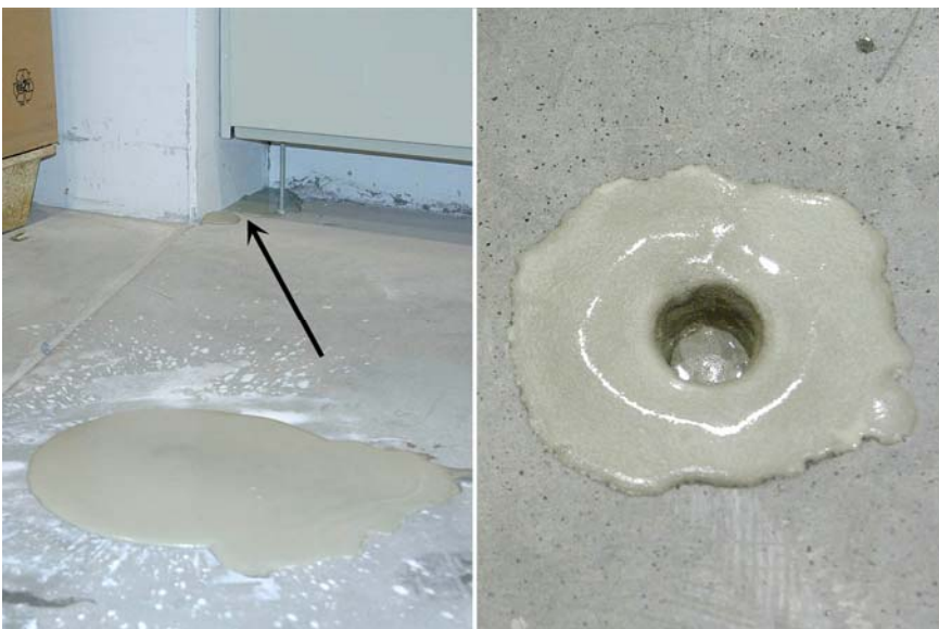
Obr. 5a Vyvěrání injektovaného materiálu v následném vrtu a na okraji desky
