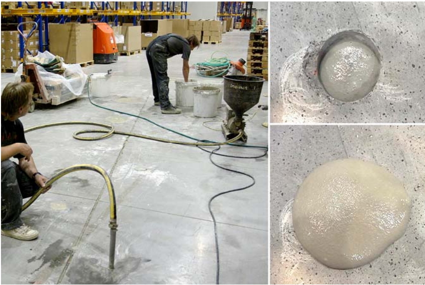
Obr. 4 Injektáž a postupné zaplnění následného vrtu vyvěrající zálivkou
