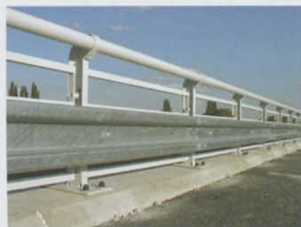
Obr. 6 Podlévání patek sloupků svodidel
