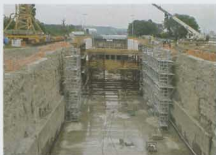
Obr. 5 Kotevní práce při opravách zdymadla
