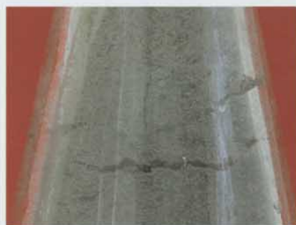
Obr. 2 Trhliny v maltě v zužující se části láhve
