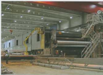
Obr. 3 Ukotvení a podlití rozsáhlé strojírenské technologie
