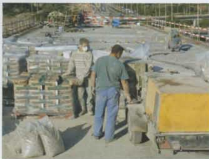
Obr. 4 Čerpání malty s možností přidavku kameniva na stavbě
