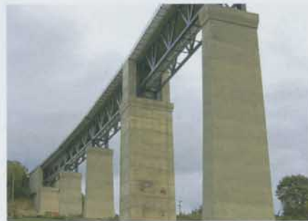
Obr. 8 Uchycení železničního mostu k betonovým pylónům
