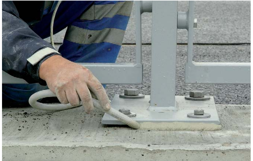
Obr. 1 – Čerpání „chemického“ bednění kolem patky sloupku
