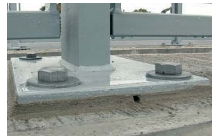
Obr. 2 – Odtokový otvor pro srážkovou vodu, injektážní otvor pro patky nevybavené otvorem od výrobce
