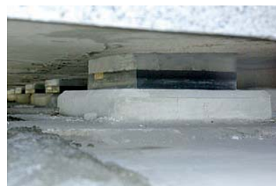
Obr. 5 – Nová ložiska mezi materiály Groutex 601 a Fill-In
