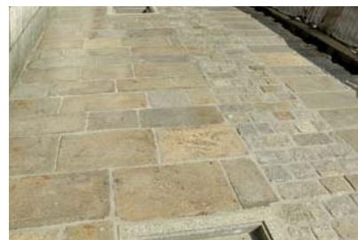
Obr. 7 – Polovina mostu po opravě
