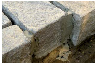
Obr. 6 – Zatmelení bočních spár proti vytékání
