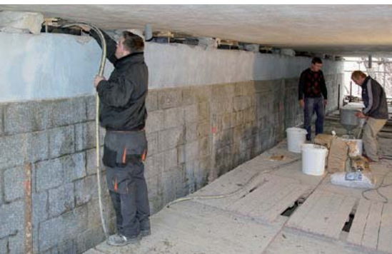
Obr. 3 – Čerpání Groutex 601 jako základ pod ložisko
