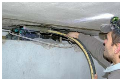
Obr. 4 – Injektáž materiálu Groutex Fill-In
